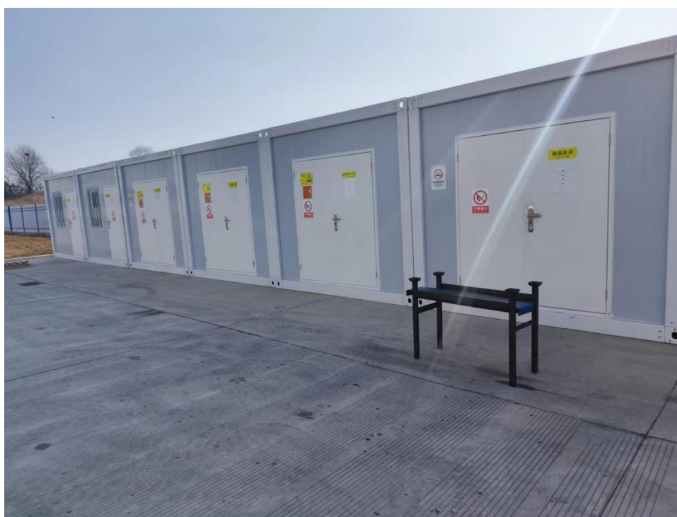
图 3-4 固体废物治理措施
