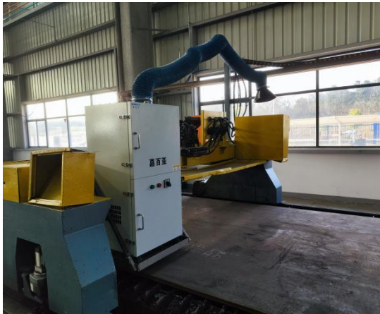
火焰切割除尘器
