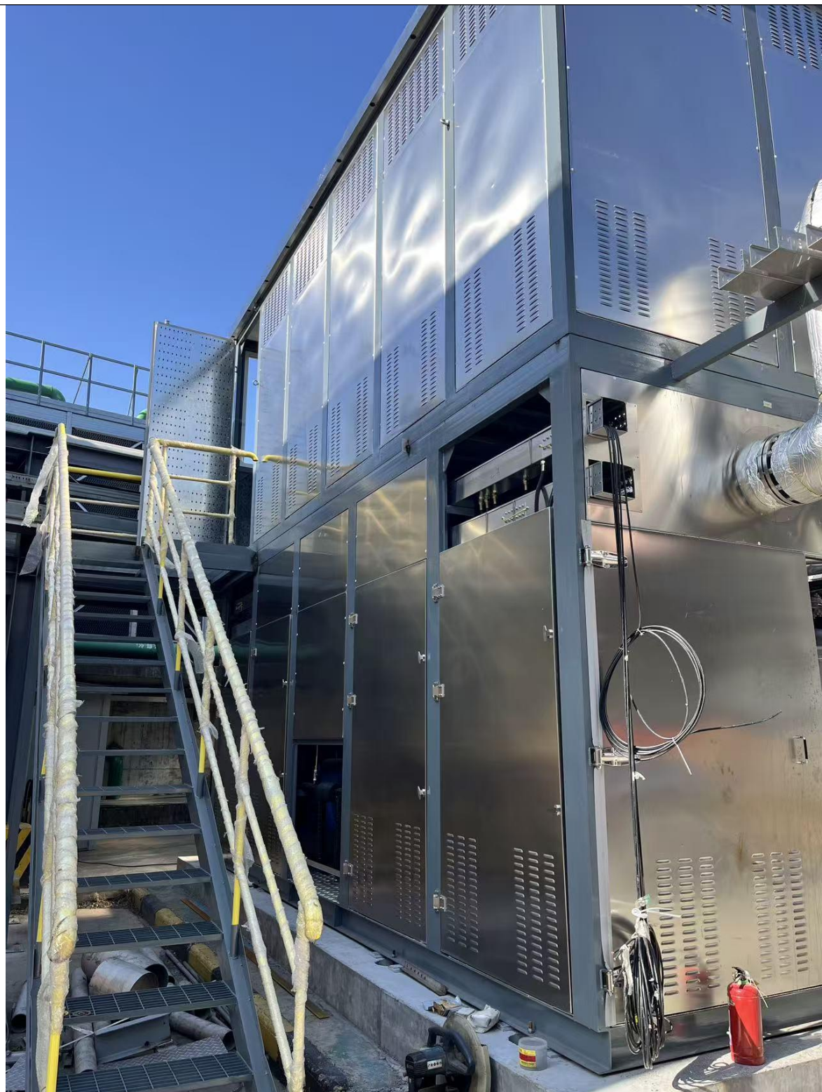
图 3-7 压缩冷凝装置图
